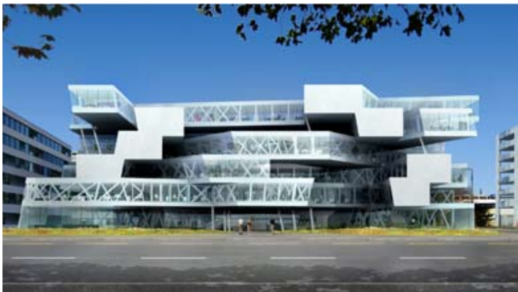
Das neue, sich im Bau befindliche Business Center. © Actelion
