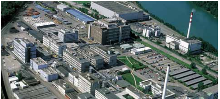
Muttens Luftaufnahme: Ansicht des Infrapark Baselland
