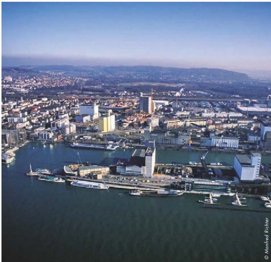
Stadthafen Kleinhüningen mit Blick auf das Gelände Basel Nord
